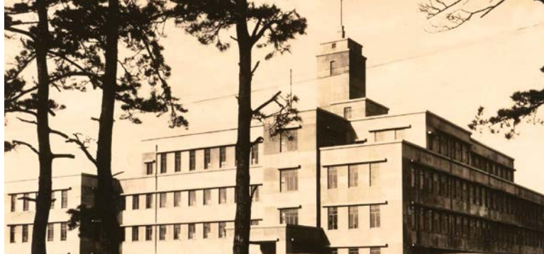
Rok 1939 - Główna siedziba Instytutu Badawczego Górnictwa po zakończeniu budowy
